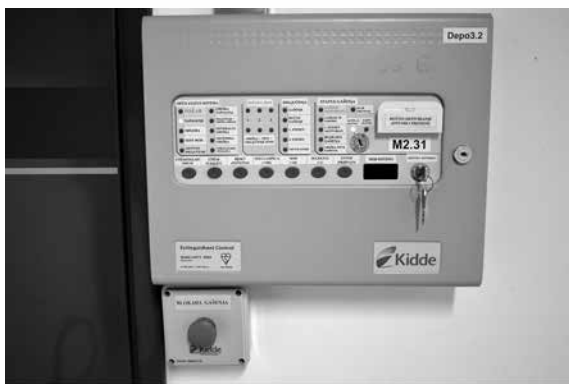
Слика бр. 4 Командна табла система NOVEC 1230 испред депоа
