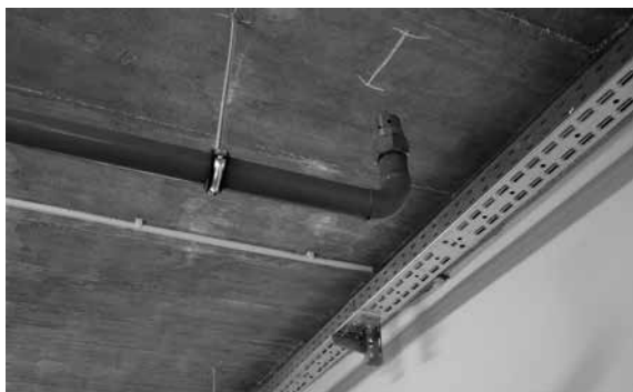
Слика бр. 3 Изглед вентила за распскавање флуида NOVEC 1230
