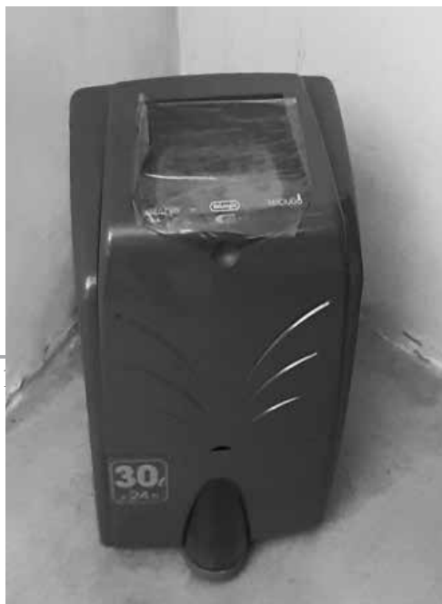
Слика 7 – Одвлаживач ваздуха у депоу Архива Југославије
